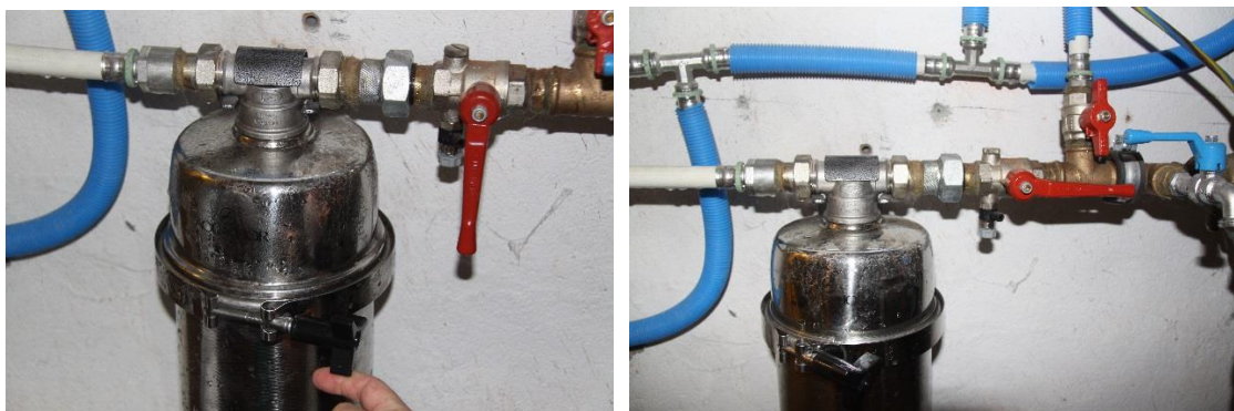
Vanne fermée (perpendiculaire au tuyau) Vanne ouverte (parallèle au tuyau)
