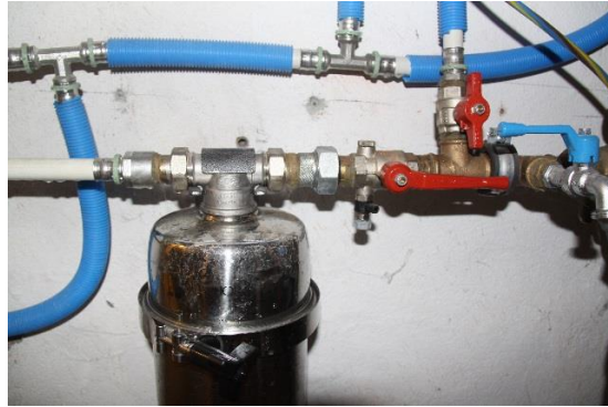
Válvula abierta (paralela a la tubería)
