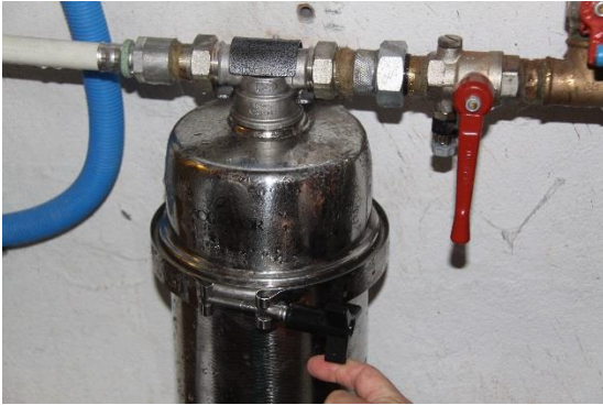
Válvula cerrada (perpendicular a la tubería)
