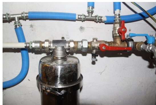
Vanne ouverte (parallèle au tuyau)
