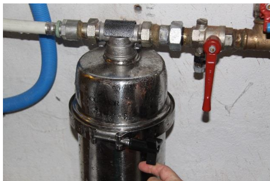
Vanne fermée (perpendiculaire au tuyau)
