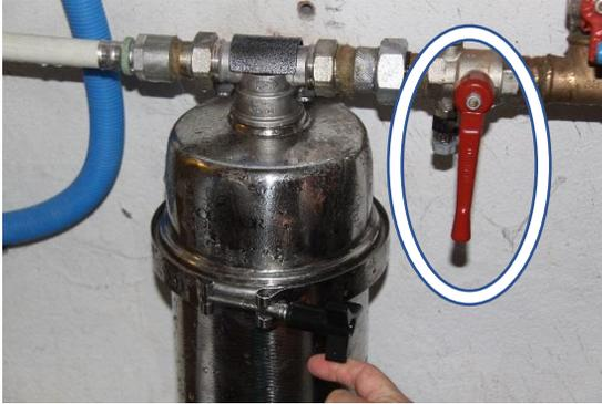
Vanne fermée (perpendiculaire au tuyau)
