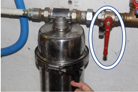
Vanne fermée (perpendiculaire au tuyau)
