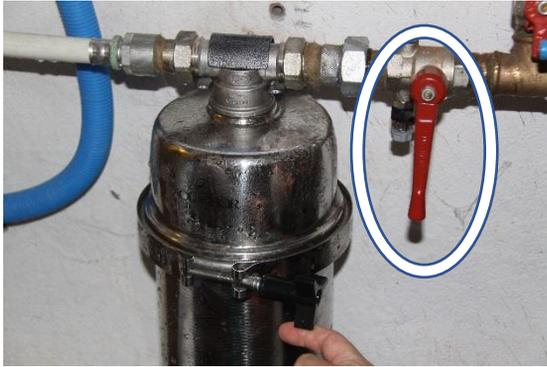
Vanne fermée (perpendiculaire au tuyau)
