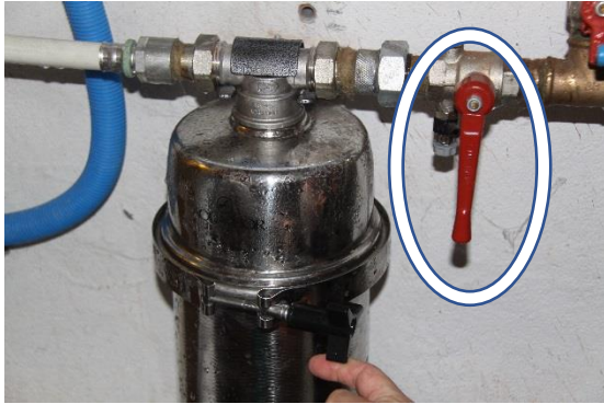
Vanne fermée (perpendiculaire au tuyau)
