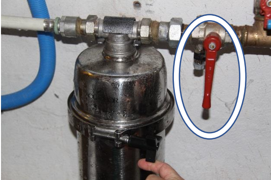
Geschlossenes Ventil (senkrecht zum Rohr)
