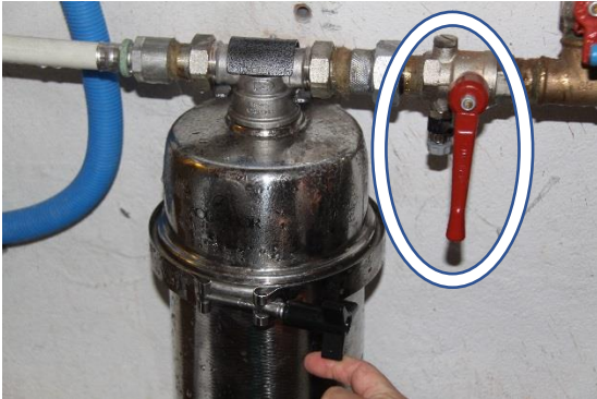
Válvula cerrada (perpendicular a la tubería)
