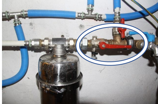
Offenes Ventil (parallel zum Rohr)
