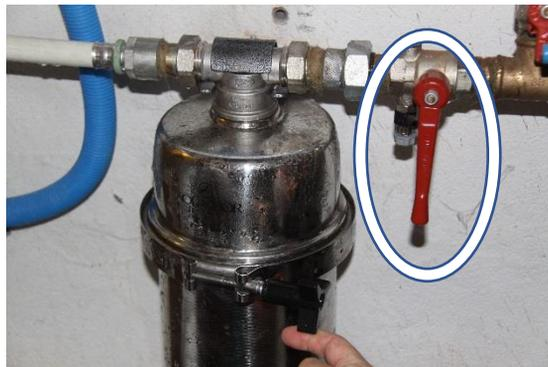
Vanne fermée (perpendiculaire au tuyau)
