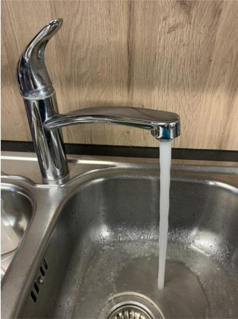
Si se va de vacaciones o después de un período prolongado de ausencia (> 8 días), deje correr el agua del grifo durante +/5 minutos para purgar el agua estancada en las tuberías sanitarias.
