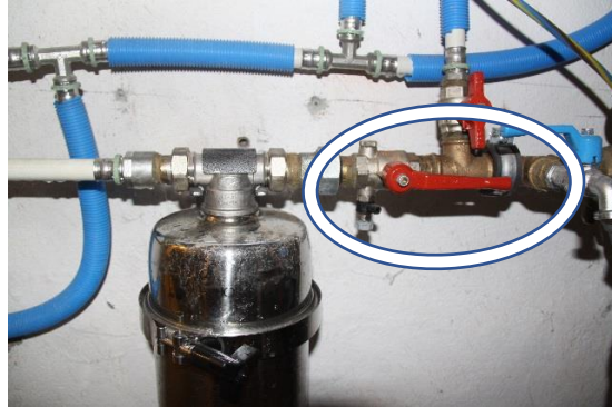
Open klep (parallel met de leiding)
